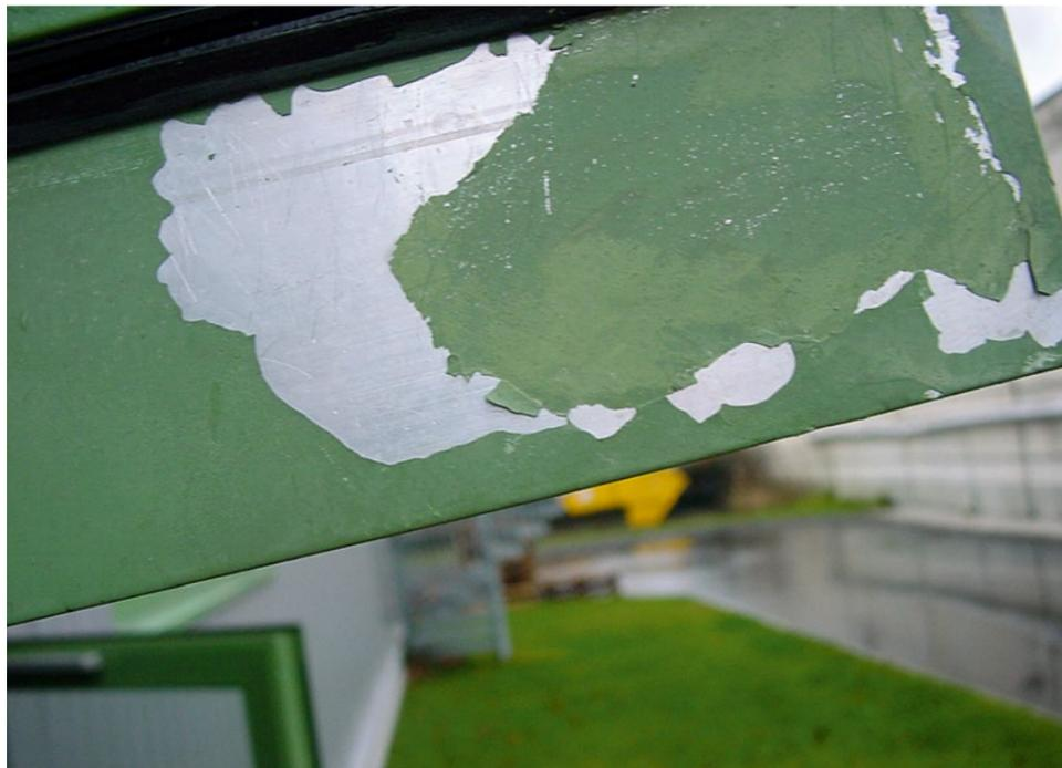
Aufgrund einer mangelhaften Vorbehandlung löst sich die Beschichtung bei diesem Vordach aus Aluminium ab.
